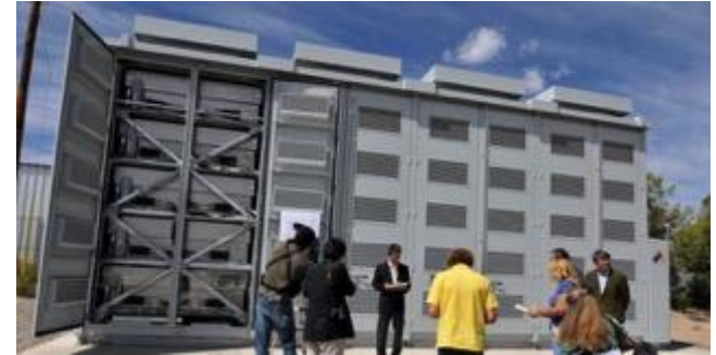
NGK 34MW - 245 MWh NaS, Rokkasho, Japan
